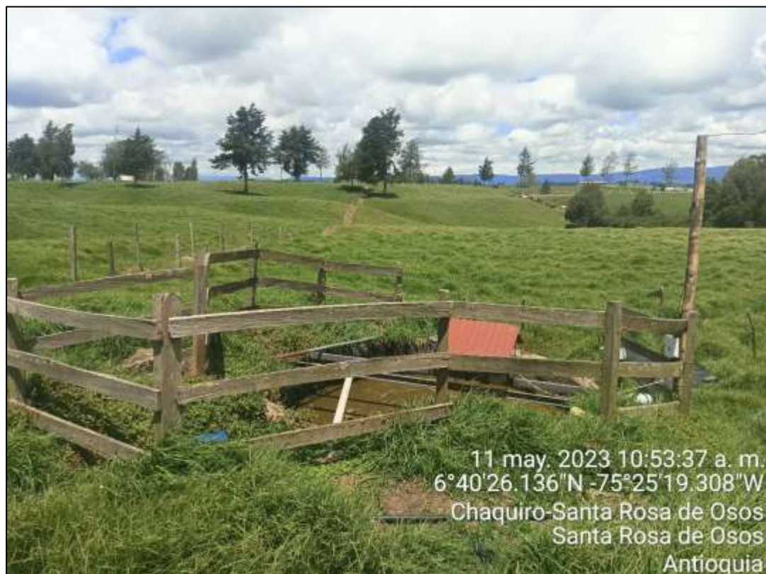
Fotografía 2. Punto de captación, evidencia de carga contaminante.
