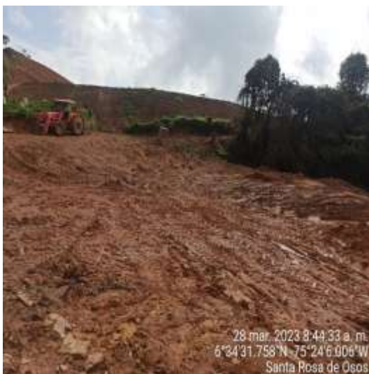
Fotografías 5 a 8. Movimiento de tierra con disposición de material sobrante sobre remanente boscoso.
