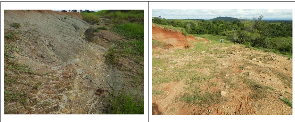
Figura 40. Evidencia de resultado de proceso continuado de erosión y pérdida de suelo.
