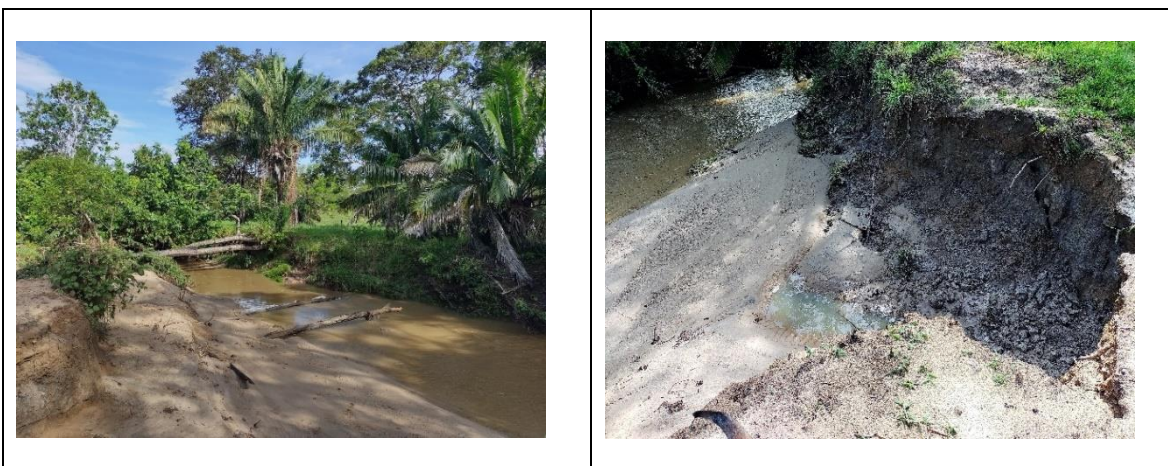
Figura 86. Evidencias de socavamiento del cauce de la quebrada La Tirana.
