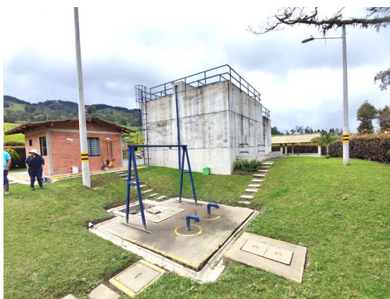
Foto 14: Panorámica de la Planta de Tratamiento de agua residual municipal.
