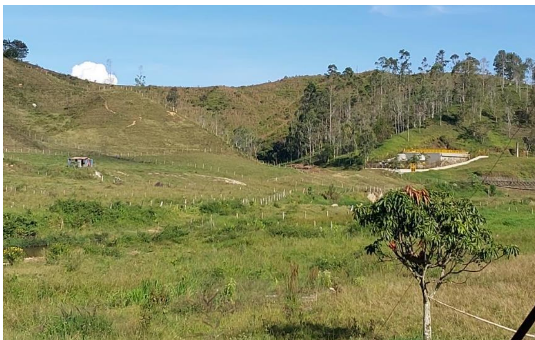
Fotografía 13. Planta de Tratamiento Aguas Residuales del municipio de Gómez Plata
