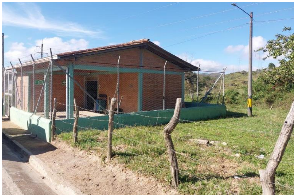
Fotografía 12. Estación de bombeo de aguas residuales del alcantarillado combinado del municipio de Gómez Plata
