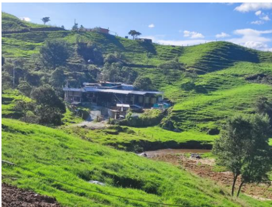
Foto 24: Instalaciones de la mina San Miguel.
