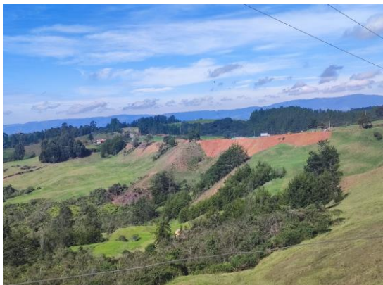
Foto 4: Depósito de material de excavación y corte en la entrada a la vereda El Roble.
