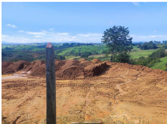
Foto 5: Depósito de material de excavación y corte de taludes aguas arriba de la bocanoma del municipio de Santa Rosa de Osos.
