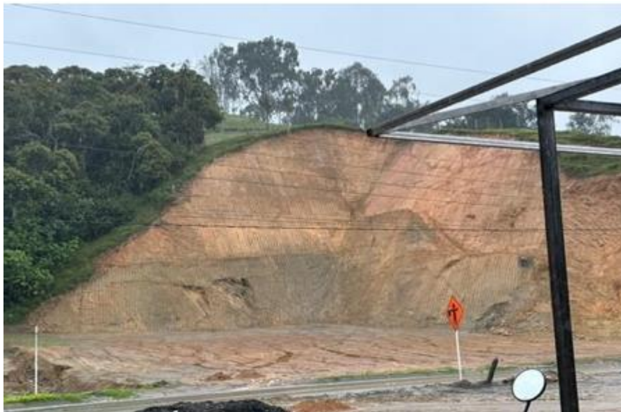
Foto 1. Evidencia fotografía del recorrido día 1, movimiento de tierra.
