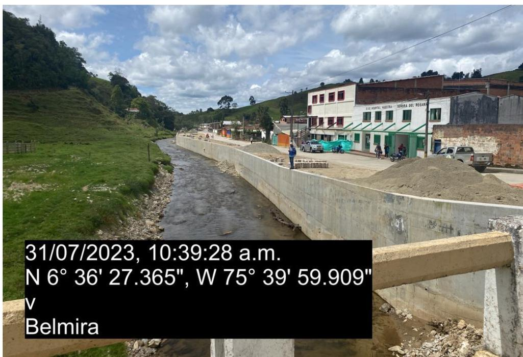
Figura de imagen 12 Muro estructural de protección contra inundaciones en zona urbana del municipio de Belmira, construido en el marco de la Gestión del Riesgo.
