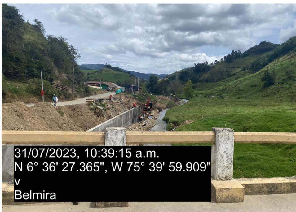
Figura de imagen 13 Construcción de muro protección contra inundaciones en zona urbana del municipio de Belmira, construido en el marco de la Gestión del Riesgo.
