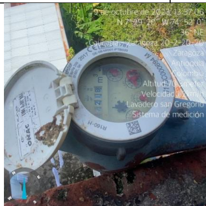
Evidencias instalación del sistema.
