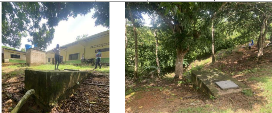
Registro 11. Evidencias fotográficas del pozo séptico.
