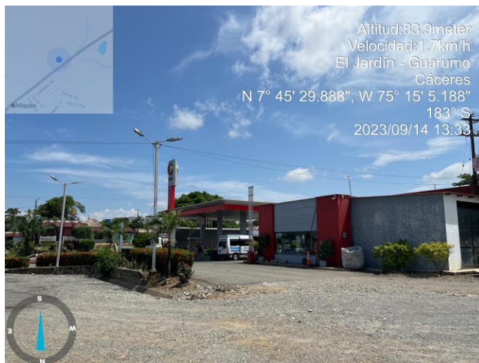
Foto 17. Localización de la ESTACIÓN DE SERVICIOS TERPEL EL LAGO
