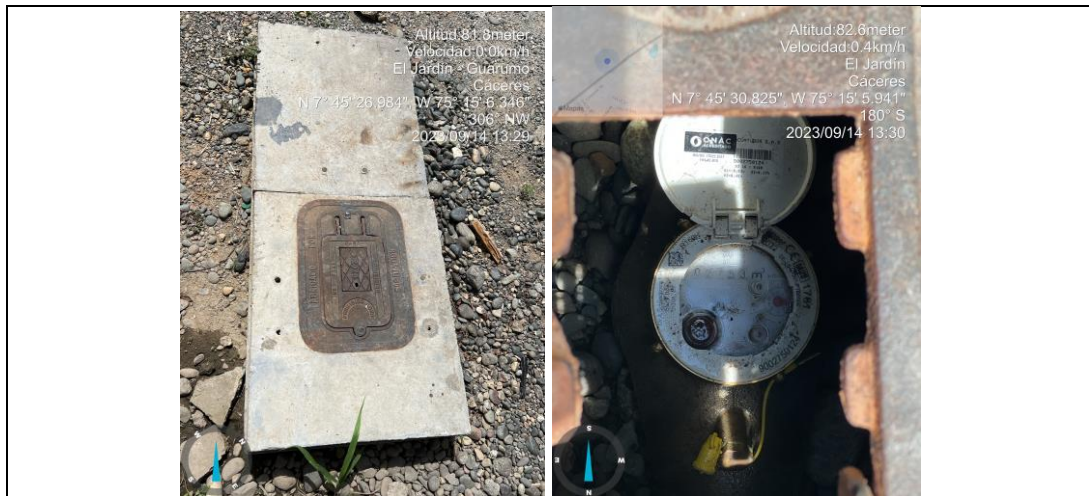
Foto 19. Infraestructura de sistema de medición y lectura (2753 m 3 )
