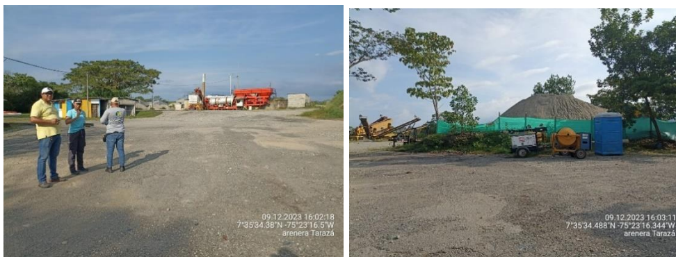
Foto 33. Evidencias de visita proyecto Arenera Tarazá
