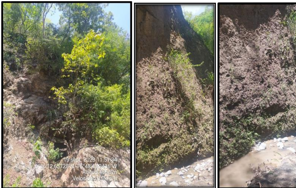
Foto 7, 8 y 9. Condiciones de los cauces de las quebradas
