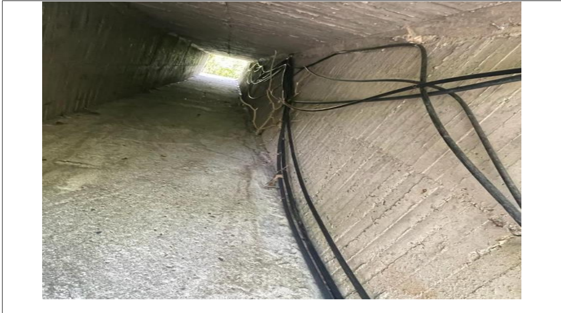
Foto 19. Mangueras que captan de la fuente La Sopera, 7 de 9 que en este sector captan agua, solo 2 están legalizadas.
