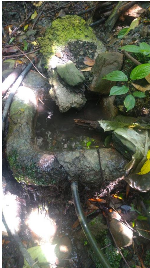
Fotografía 7. Obra de captación y control expediente HX1-2013-46
