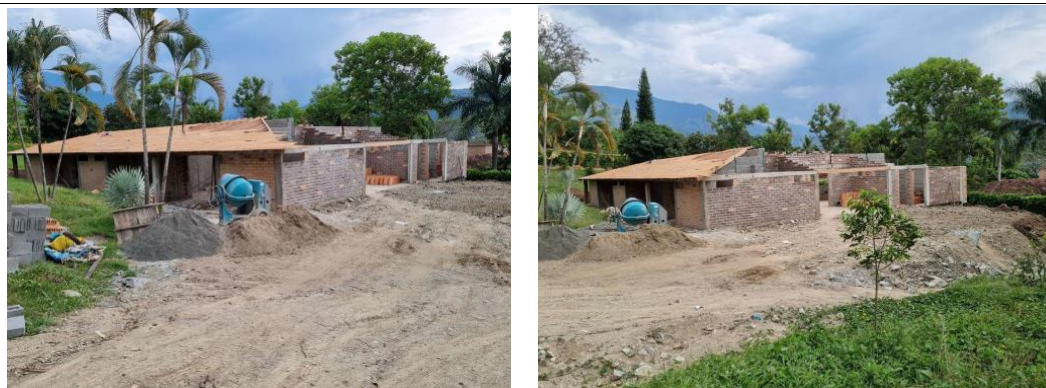
Fotografía 61-62: Sistema Tratamiento Aguas Residuales Domésticas Fuente: COE 160HX-COE2212-45267 del 22/12/2023
