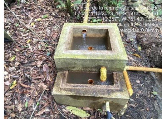
Fotografía 12-13: Obra de Captación, control y reparto – Acequia. Fuente: Corantioquia 2023.
