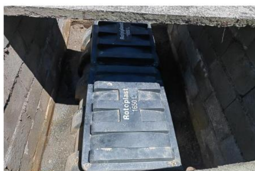
Fotografía 57-60: Sistema Tratamiento Aguas Residuales Domésticas Fuente: COE 160HX-COE2305-17767 del 03/05/2023
