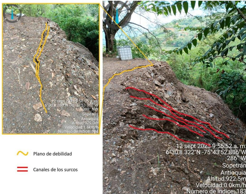
Foto 24. Procesos erosivos y plano de debilidad de talud
