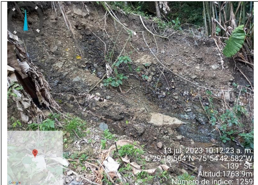
Fotografía 6. Deslizamientos e inestabilidad de taludes por deforestación
