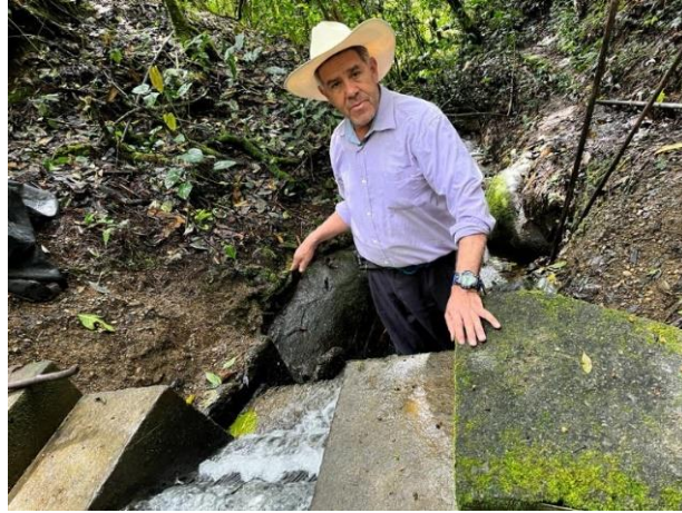
Fotografía 7: Bocatoma Acueducto zona urbana Caicedo. Fuente: Corantioquia 2023.
