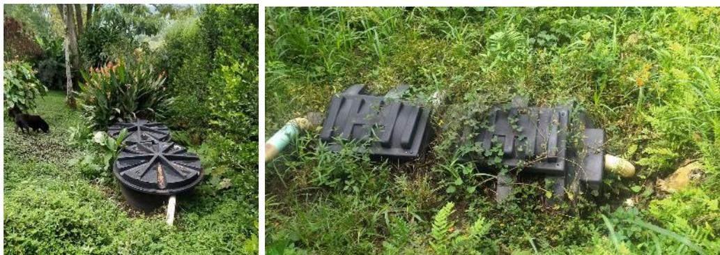
Imagen 15. Tipología de los tanques sépticos que se instalan en el saneamiento básico rural
