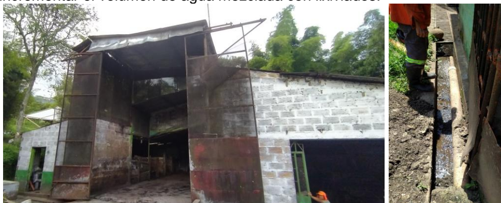
Foto 12 y 13. Falta de cubrimiento en los aleros de la estructura y cañuela para evacuación de lixiviados
