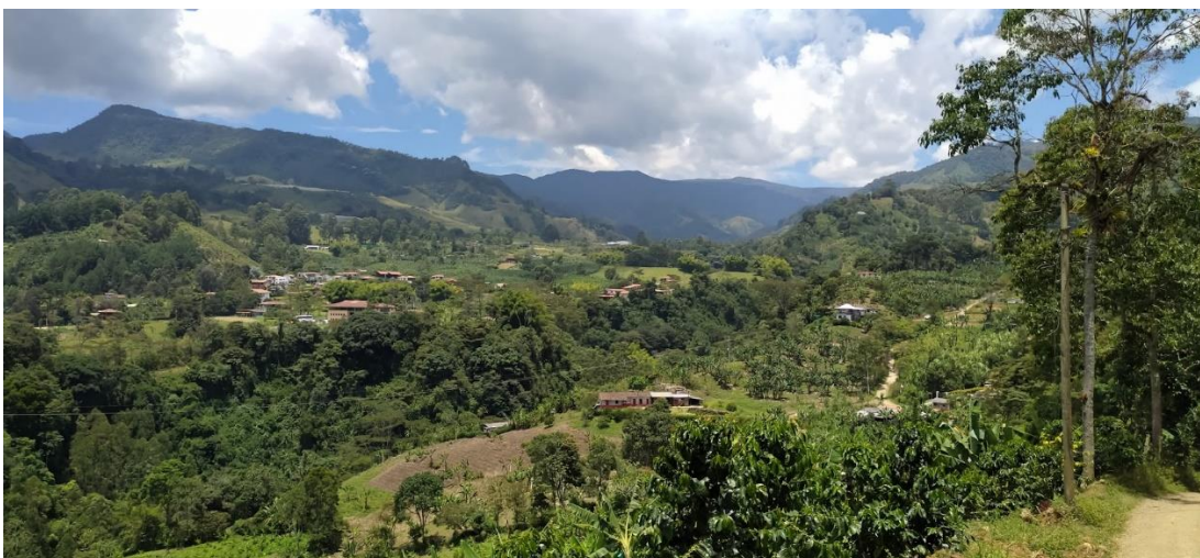
Foto 16. Panorámica de establecimiento de edificaciones en el suelo rural
