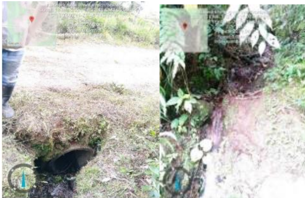
Imagen No. 1 y 2: Obras hidráulicas en buen estado y con mantenimiento permanente
