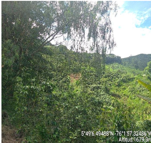
Foto 6. Pequeño evento de remoción en masa al costado nororiental del resguardo.
