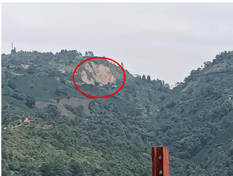
Foto 4. Proceso erosivo activo en uno de los afluentes de la quebrada La Quebrada, ubicación 5^{\circ}56'59.58''N 75^{\circ}38'48.52''O , cota 1929 m.s.n.m.
