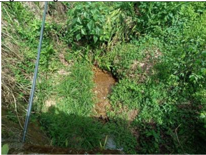
Quebrada El Mango, cota 1.559 m.s.n.m.
