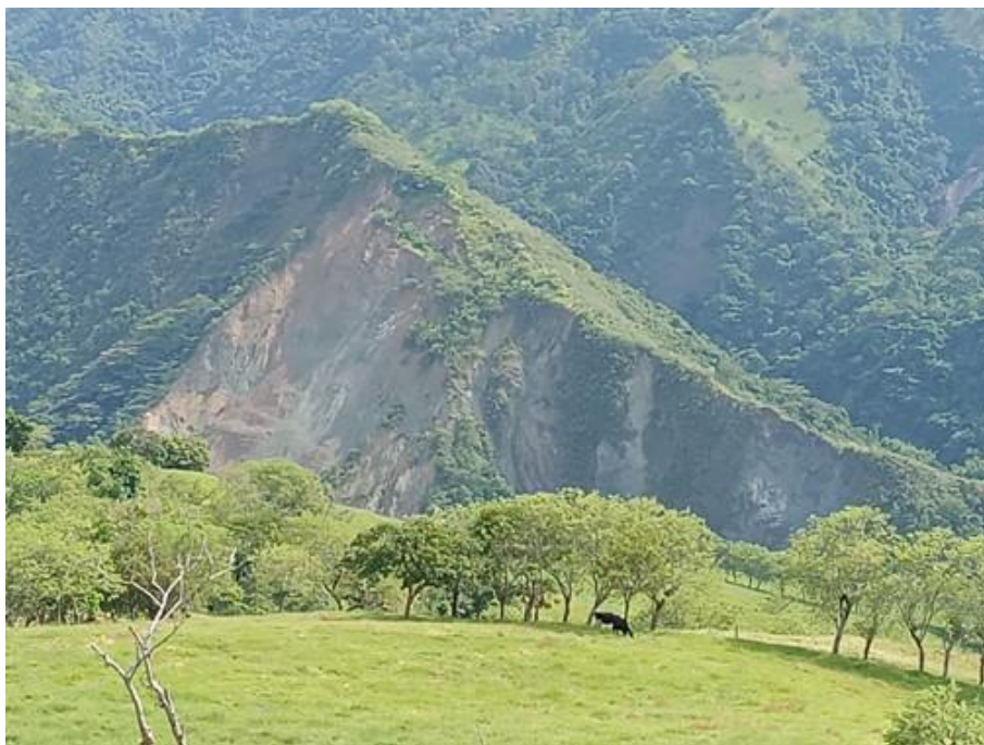
Foto 1. Procesos erosivos en el río Poblancito, ubicación 5^{\circ}53'56.31''N 75^{\circ}37'37.14''O , cota 1044 m.s.n.m.
