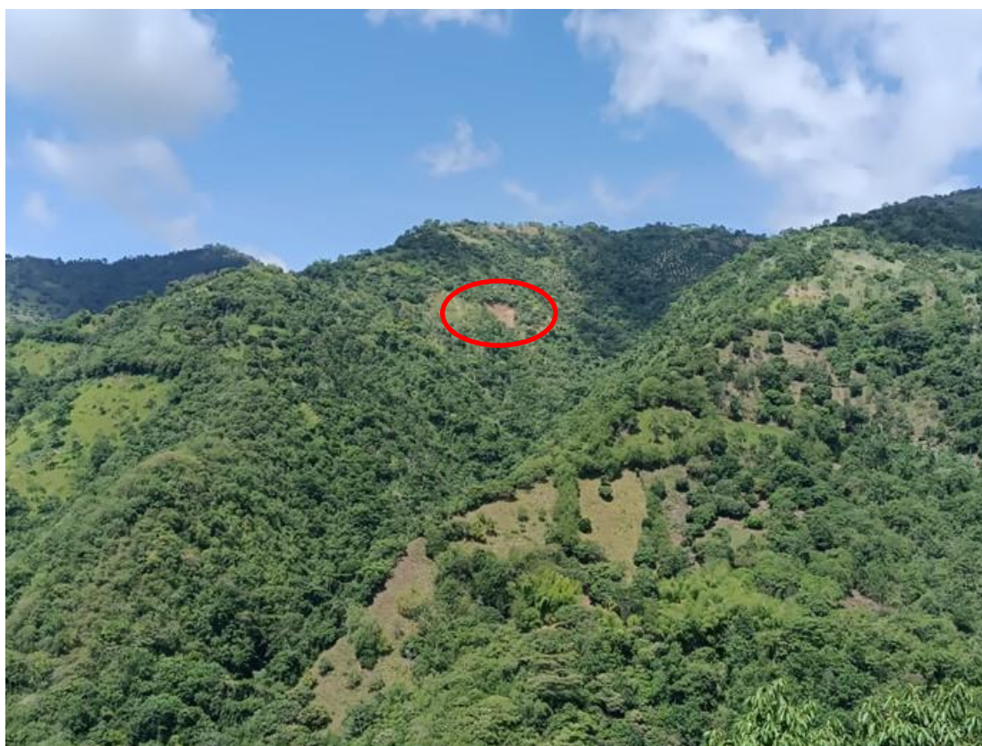
Foto 1. Desgarres de suelo dentro de la microcuenca de la quebrada Guamal, Unidad Territorial CAUT_DIRECTOS AL RIO BUEY, municipio de Santa Bárbara.
