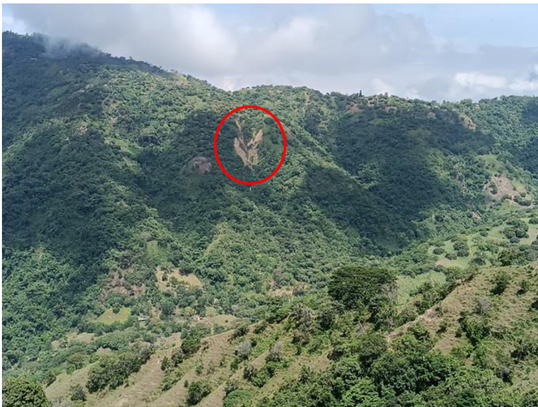
Foto 2. Desgarres de suelo dentro de la microcuenca de la quebrada Guamal, Unidad Territorial CAUT_DIRECTOS AL RIO BUEY, municipio de Santa Bárbara.
