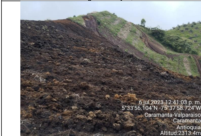
Fotografía 3, Adecuación de terreno para siembra de Aguacate Hass, municipio de Caramanta.
