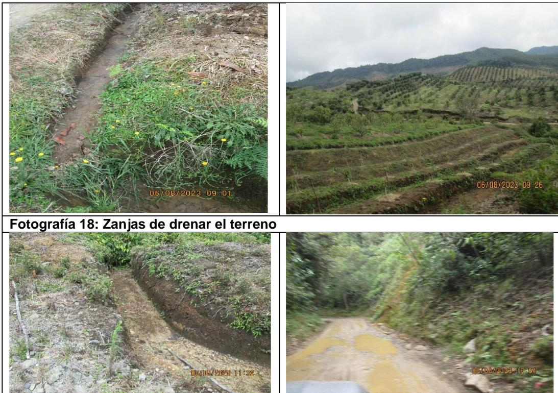
Fotografía 18: Zanjas de drenar el terreno
