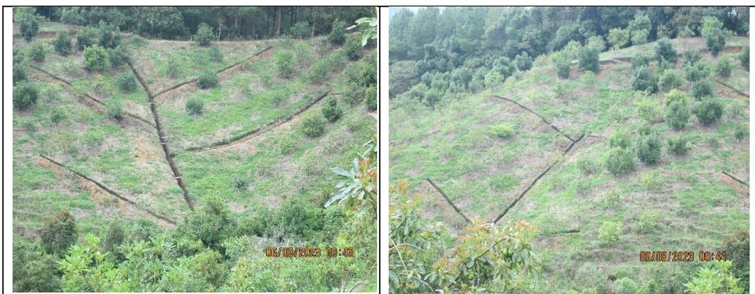
Fotografía 17: Zanjas de drenar el terreno
