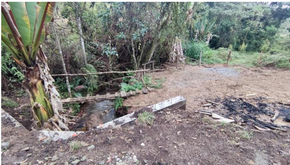
**Fotografía 9. Box Culvert fuente La Sola, pequeña explanación y material vegetal incinerado.**
