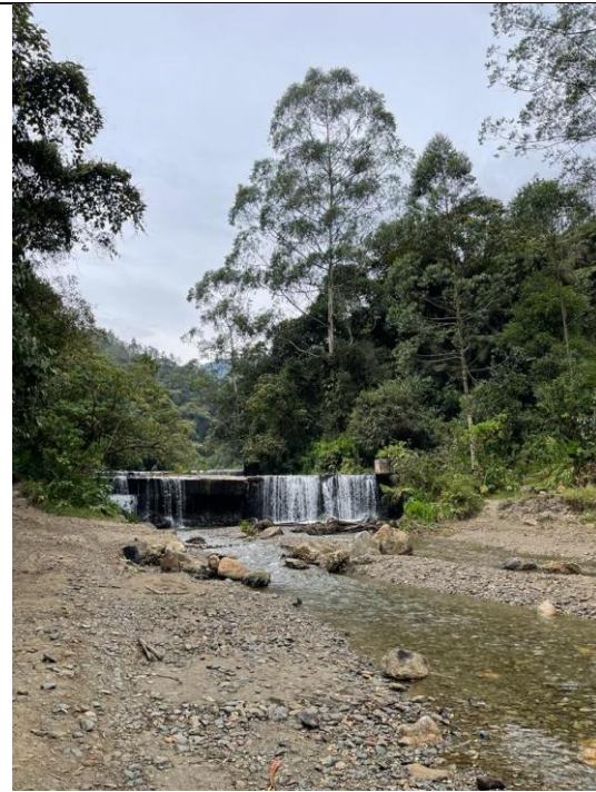
Foto 1, Presas construidas en el río para retención de sólidos suspendidos y en general material de arrastre
