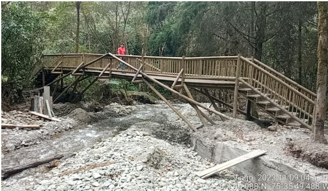
Foto No 01: Puentes Peatonal y Muro de Protección Marginal Margen Derecha del Río
