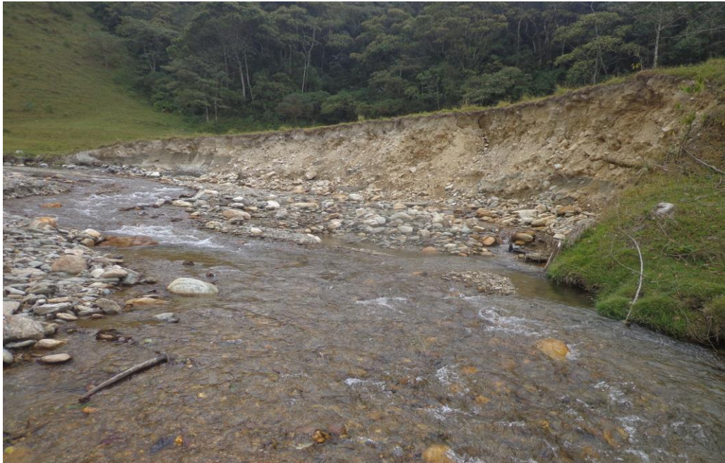
Foto No 03: Talud vertical margen izquierda del río con fuertes procesos de erosión y socavación con pérdida de banca
