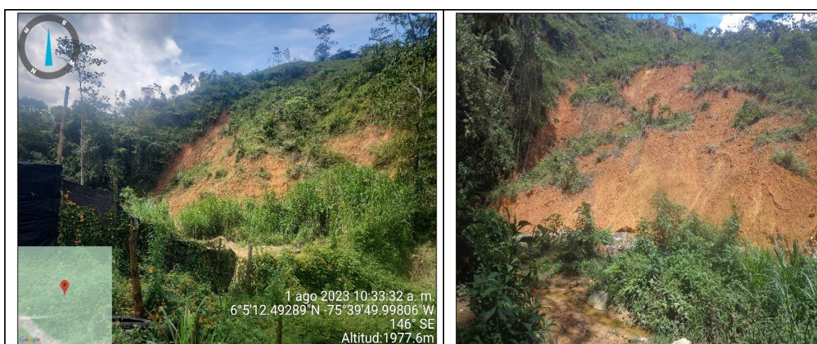
Foto 9 y 10. Panorámica del movimiento en masa.
