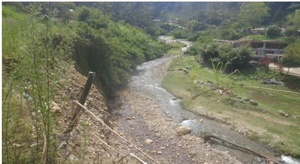
Fotografía 29, Infraestructura en Franja de Retiro y Cercana Punto Crítico de Falla.
