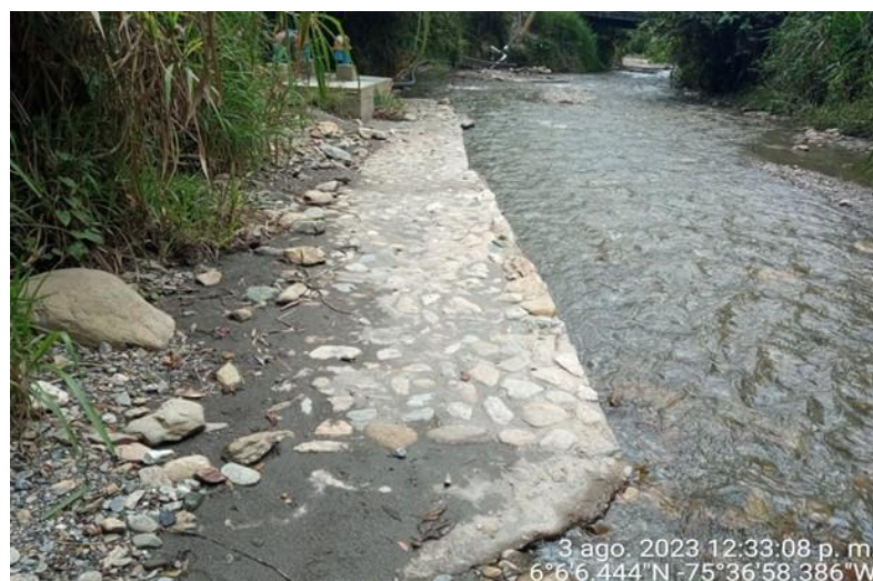
Fotografía 30, Ocupación Cauce La Miel Tanque Captación Acueducto Planta de Alimentos FRIKO.
