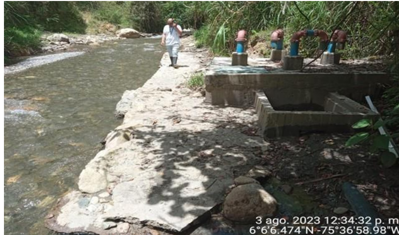
Fotografía 31, Ocupación Cauce La Miel Tanque Captación Acueducto Planta de Alimentos FRIKO.
