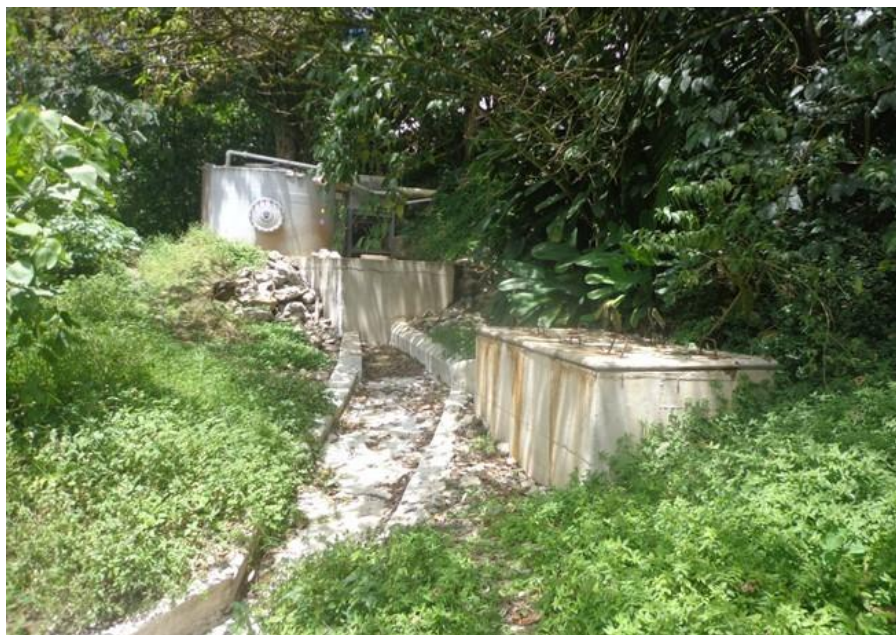
Fotografía 33, PTAR Planta de Alimentos FRIKO Ocupando Franja Retiro Quebrada La Miel
