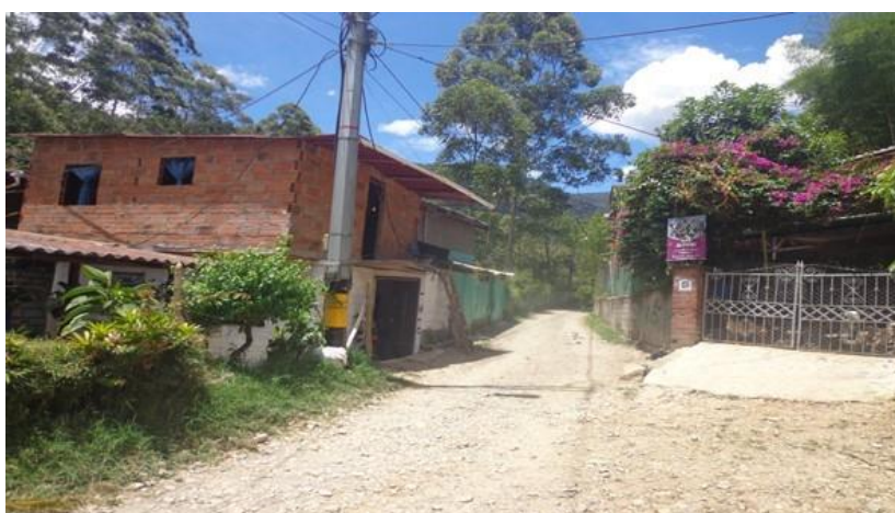
Fotografía 25, Infraestructura en Franja de Retiro y Cercana Punto Crítico de Falla.
