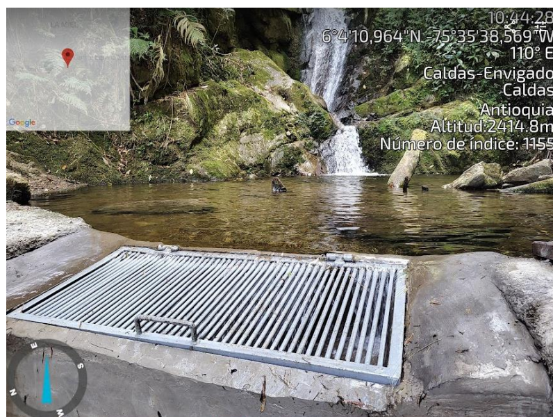
Fotografía 8, Captación del Acueducto Multiveredal Corrala, Corralita y Corrala parte baja
