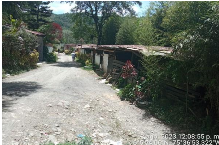
Fotografía 26, Infraestructura en Franja de Retiro y Cercana Punto Crítico de Falla.
