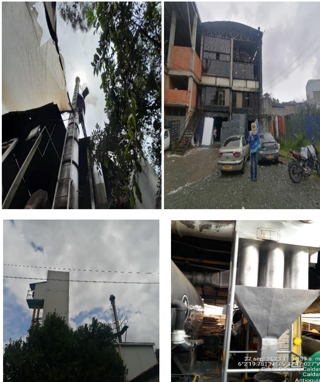
Fotografías 1,2,3,4, Visitas control a fuentes fijas
