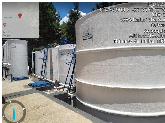
Fotografía 9, tanques de almacenamiento Acueducto
