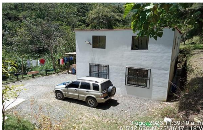
Fotografía 24, Infraestructura en Franja de Retiro y Cercana Punto Crítico de Falla.
