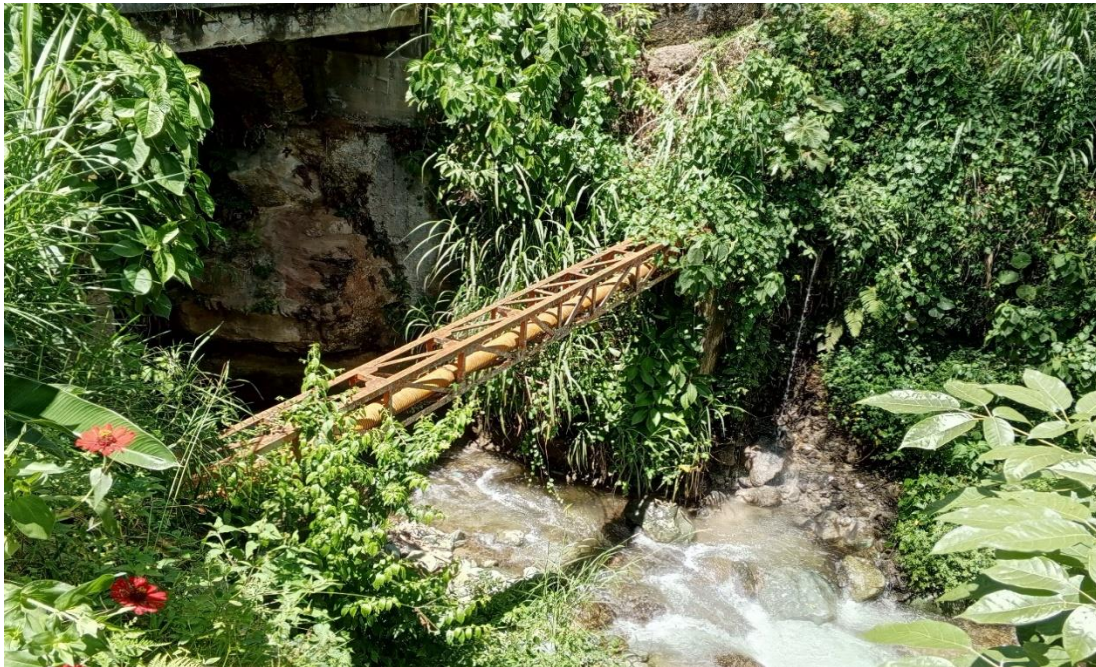
Descarga principal de la zona urbana a quebrada La Aburreña.
