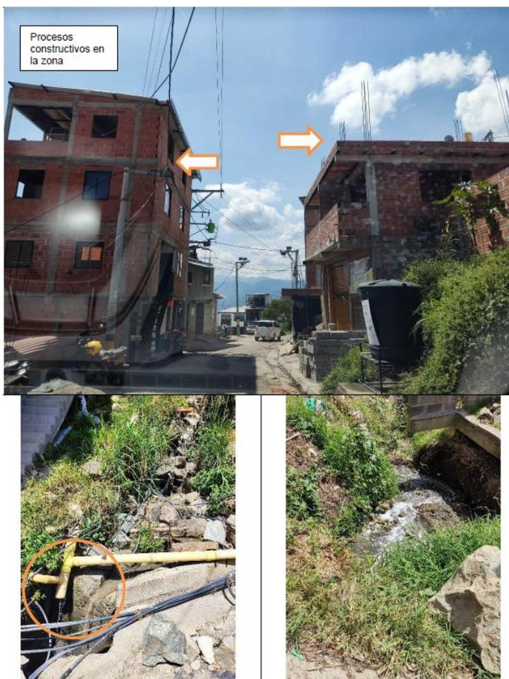
Imagen 23. Densificación y crecimiento en altura en la vereda El Picacho, y aguas residuales domésticas colectadas de forma empírica mediante mangueras, Medellín.
