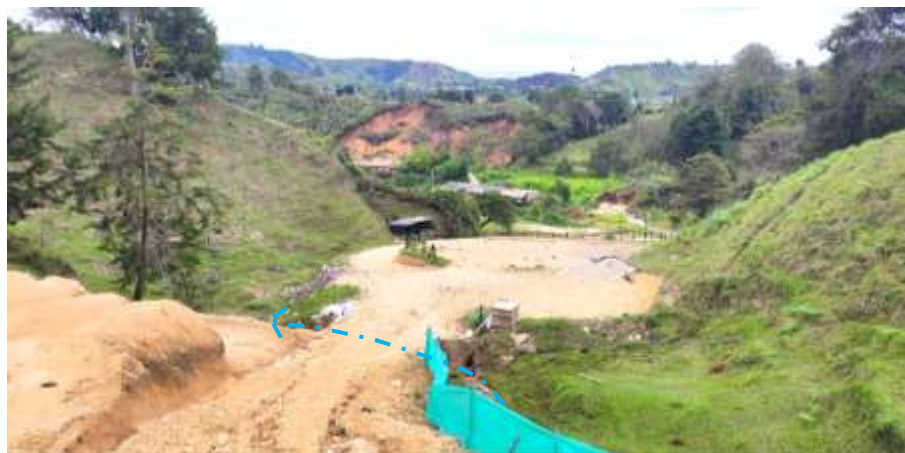
Foto 6: Segundo cruce de la vía interna de la parcelación con la quebrada Sin Nombre (Código 18414).
