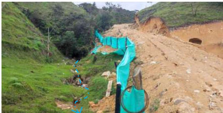
Foto 8: Sarán verde instalado entre 1 a 3 metros del cauce de la quebrada Sin Nombre (Código 18414).
