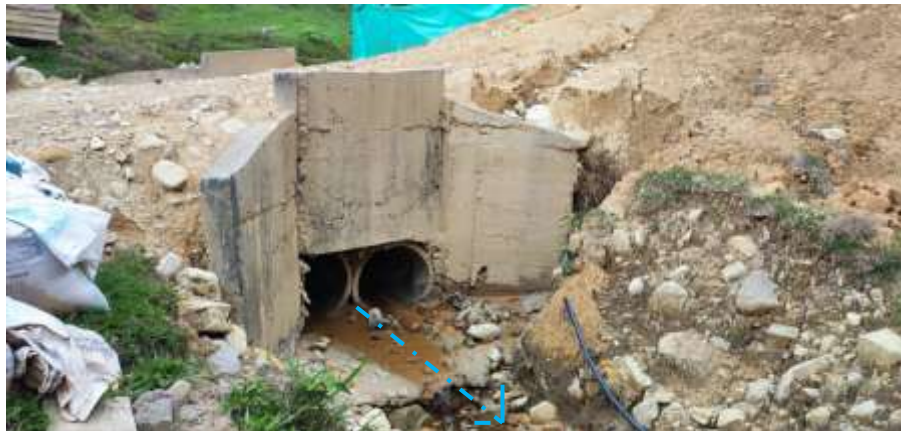
Foto 7: Descole de obra transversal donde discurre la quebrada Sin Nombre (Código 18414).
