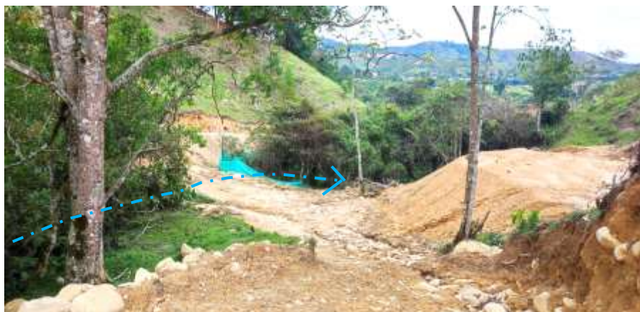
Foto 2: apertura de vía interna de la parcelación sobre la quebrada Sin Nombre (Código 18414).
