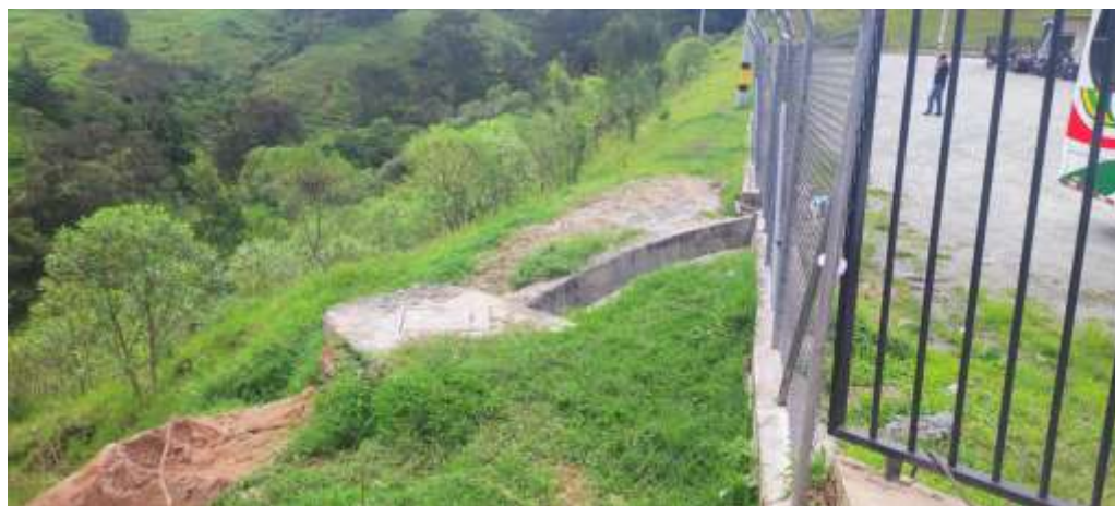
Foto 10: Cárcamo y caja de inspección de aguas lluvias del área de parqueo de la terminal de transporte de Yarumal.
