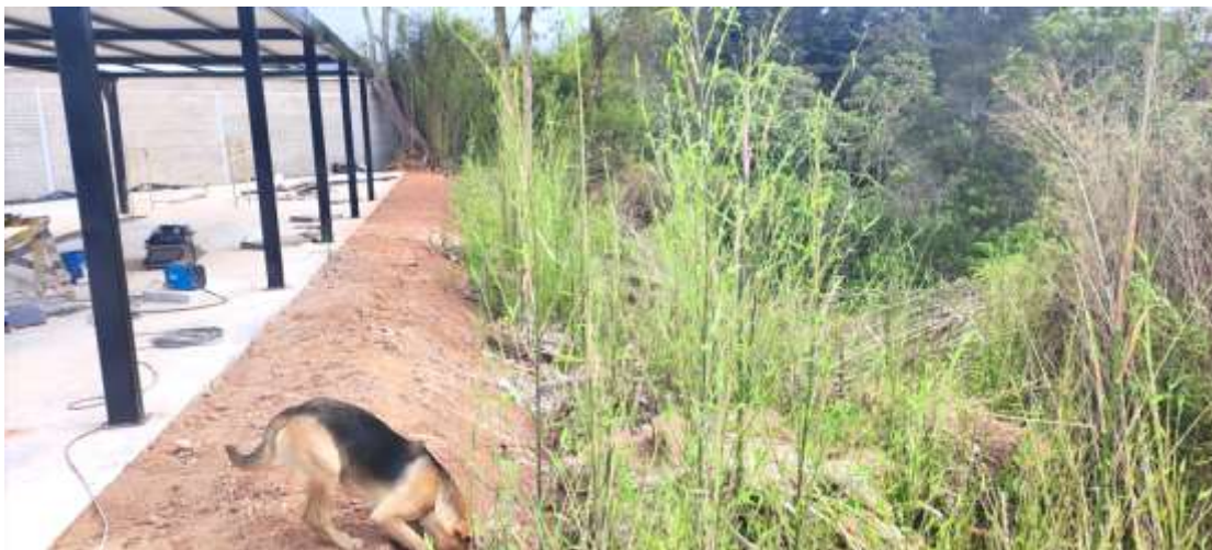
Foto 6: Talud posterior del lavadero de carros, donde se evidencia el guadua.
