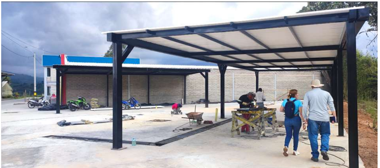
Foto 2: Avance de la obra de la construcción del lavadero de carros.
