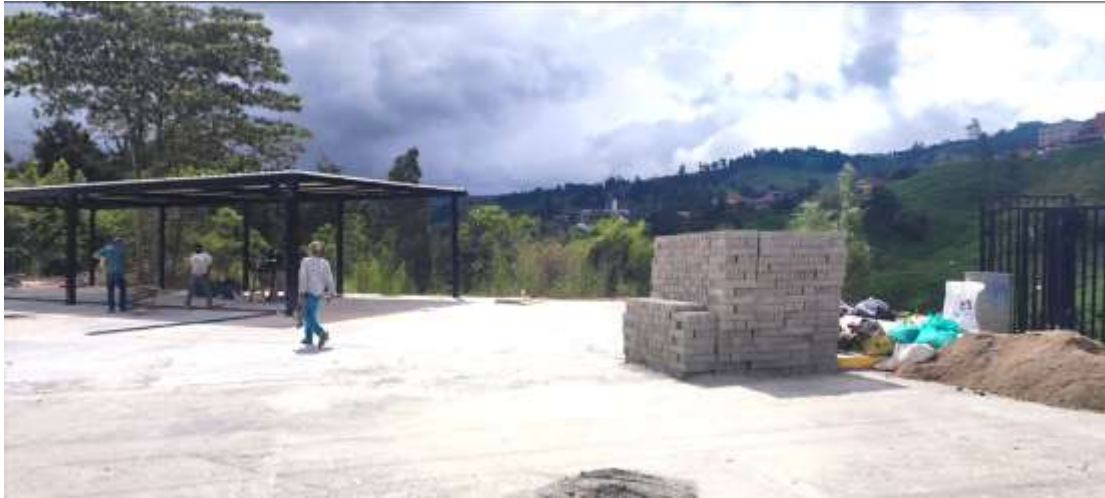
Foto 1: Estado de la construcción del lavadero de carros.
