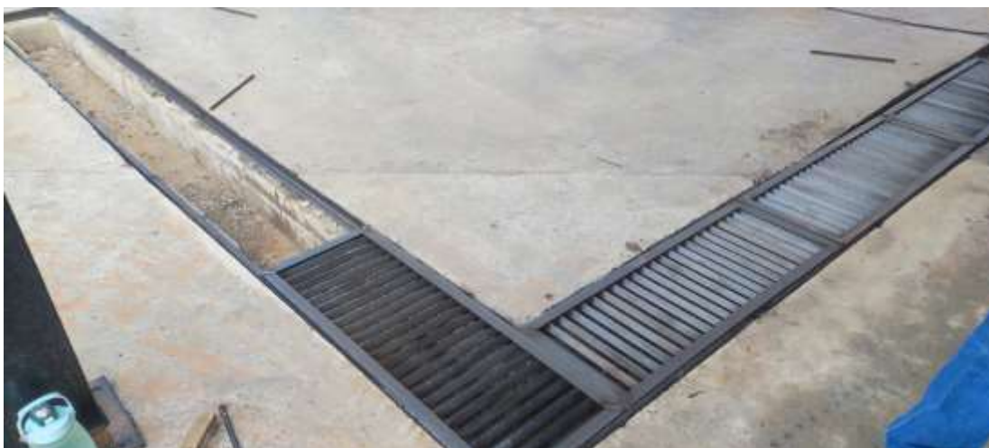
Foto 4: Cárcamos construidos en el lavadero de carros.
