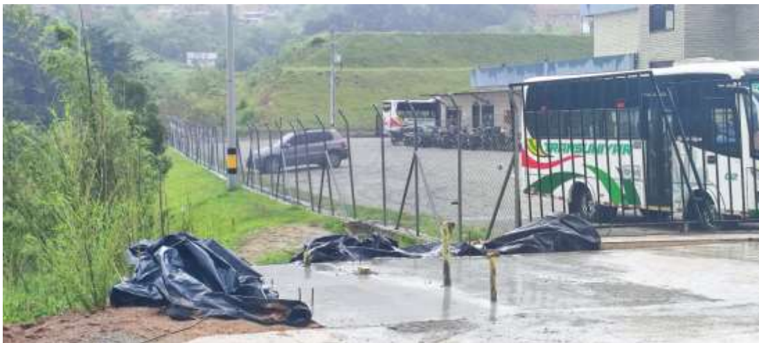
Foto 3: Preparación del terreno para la caseta de administración.
