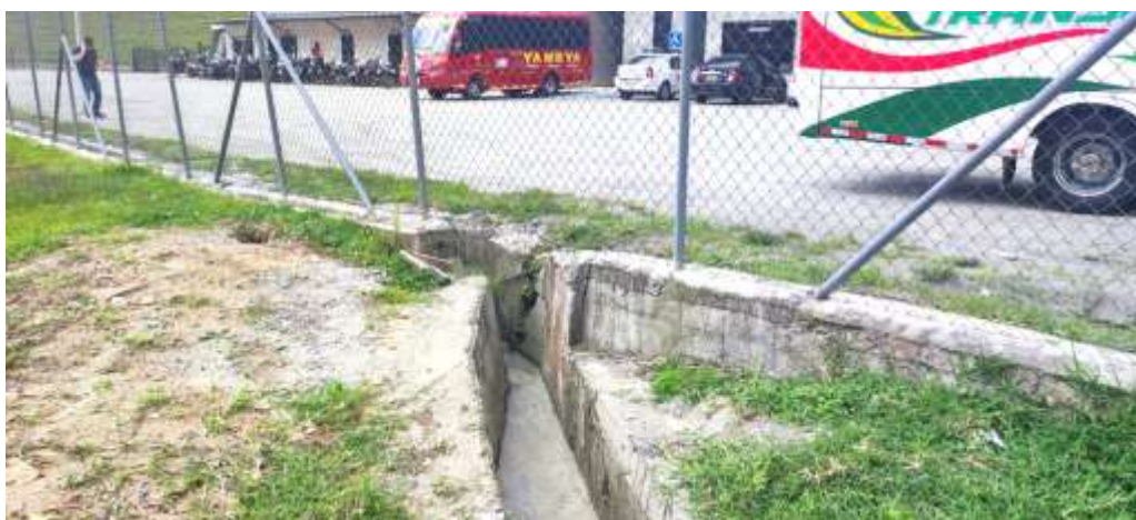
Foto 11: Cárcamo de agua lluvia sin rastro de residuos de aceites o grasas.
