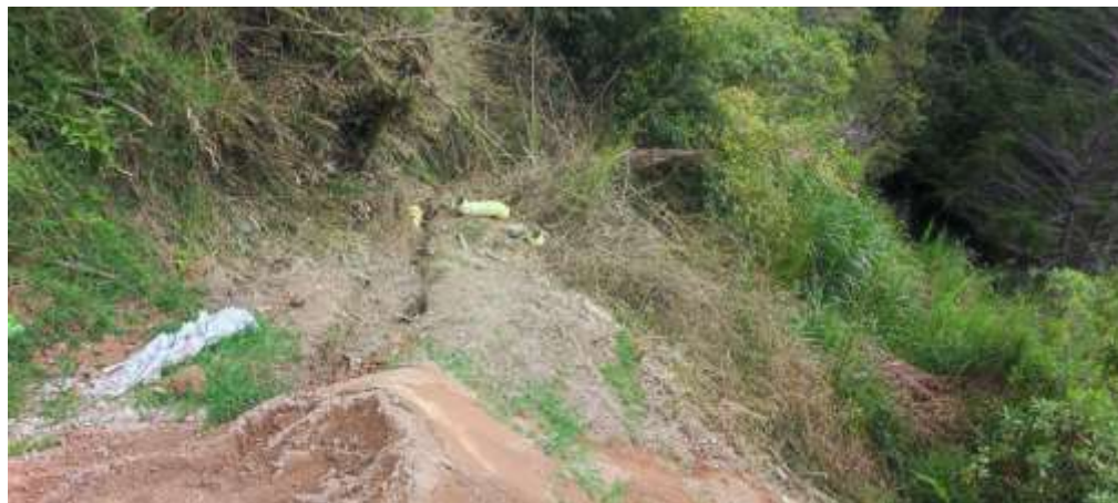
Foto 12: Área donde se observa las tuberías de PVC enterradas.
