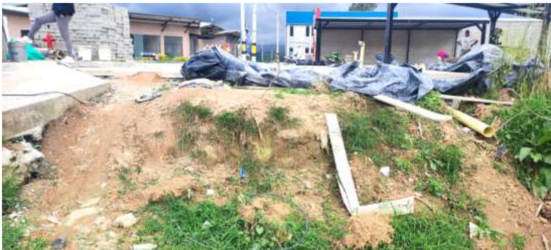
Foto 7: Residuos sólidos dispuestos sobre el talud posterior del lavadero de carros.
