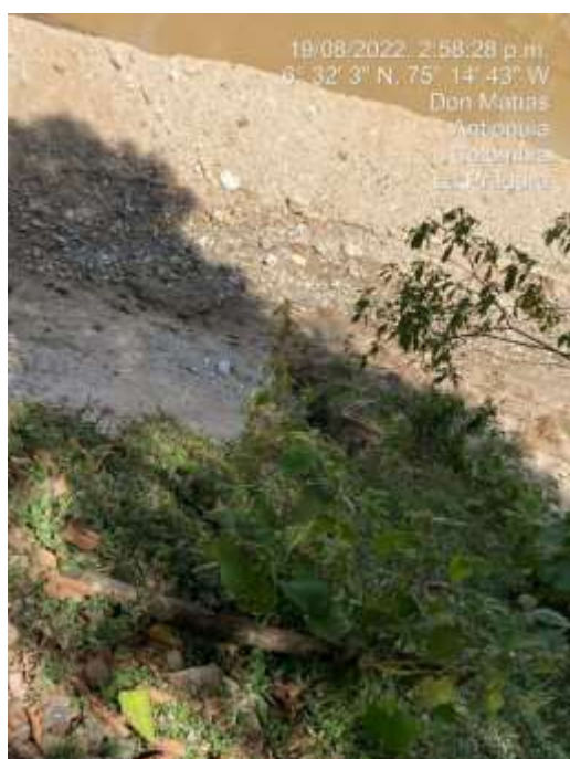
Fotografía 5. Problemas de Erosión, por actividad minera
