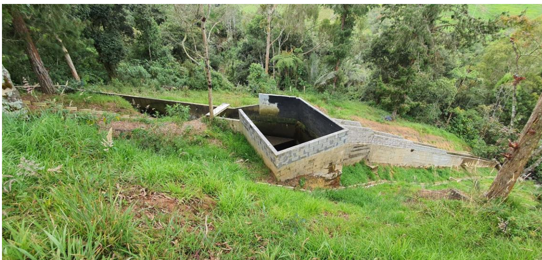
Foto 1. Canal de conducción en el sitio de llegada a casa de máquinas. Se observa la conformación de un canal para el manejo de las aguas de escorrentía.
