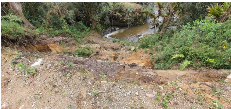
Fotos 2 y 3. Sector del canal de conducción con presencia de procesos erosivos. Se observa la implementación de tratamientos geotécnicos para el control de la erosión.
