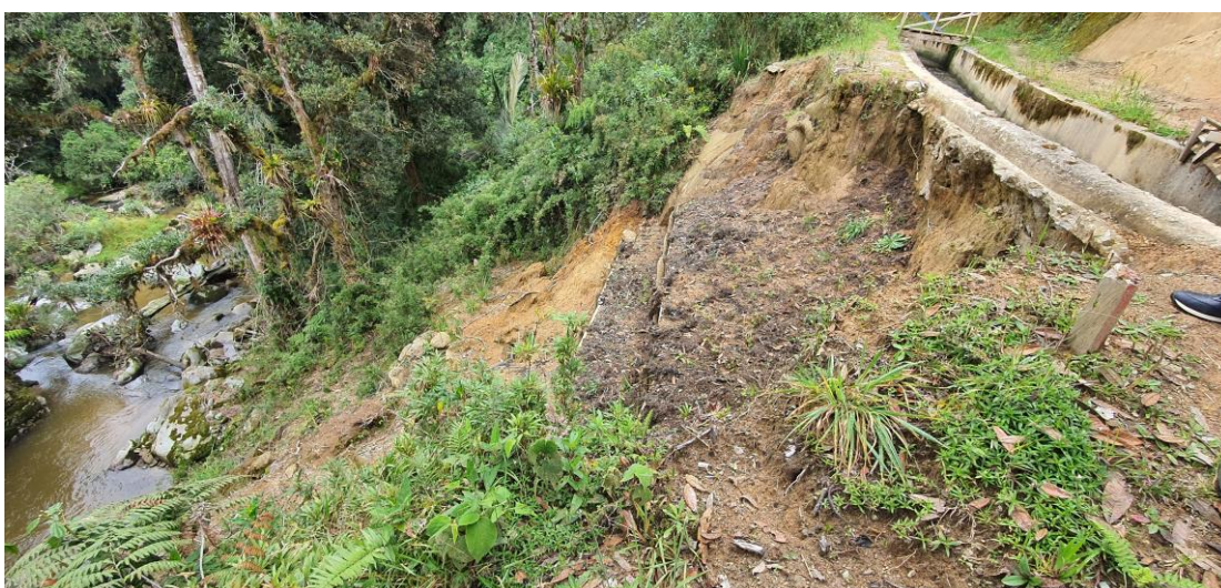
Foto 1. Canal de conducción en el sitio de llegada a casa de máquinas. Se observa la conformación de un canal para el manejo de las aguas de escorrentía.
