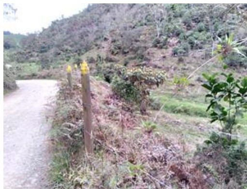
Estacones inmunizados y pintura en la parte superior, no se detecta la pintura "vareta" generando contaminación a las fuentes de agua.
