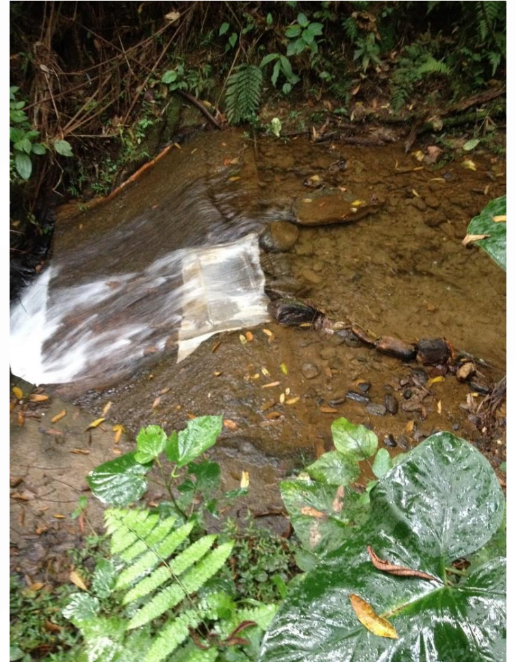
Captación de fondo. Quebrada La Miel. Caldas, Antioquia.
