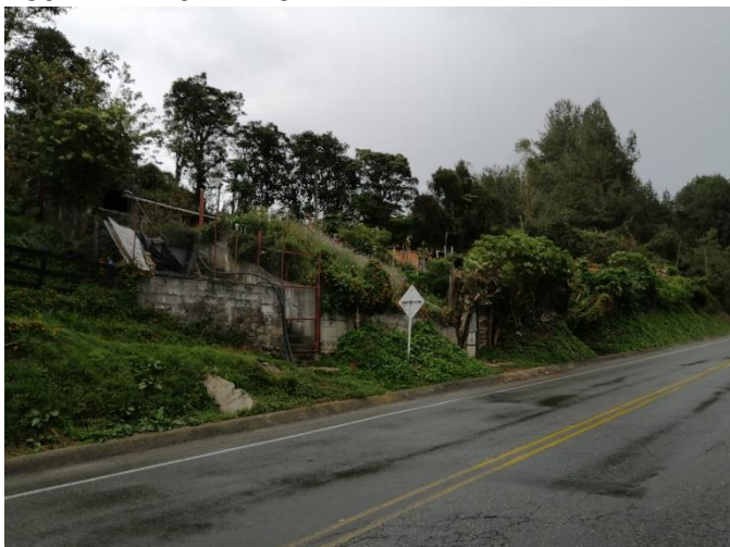
Imagen No.3. Viviendas localizadas sobre la margen izquierda de la via Santa Rosa de Osos – corregimiento Hoyorrico
