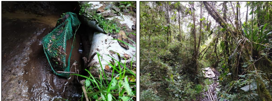
Fotografía 1 y 2. Captación de agua superficial y obra de captación de agua del Señor Octavio Álvarez Tobón
