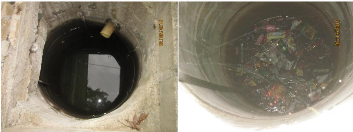
**Foto 4.** Izquierda: aljibe con tubería de descarga de aguas residuales. Derecha: aljibe con basura.
