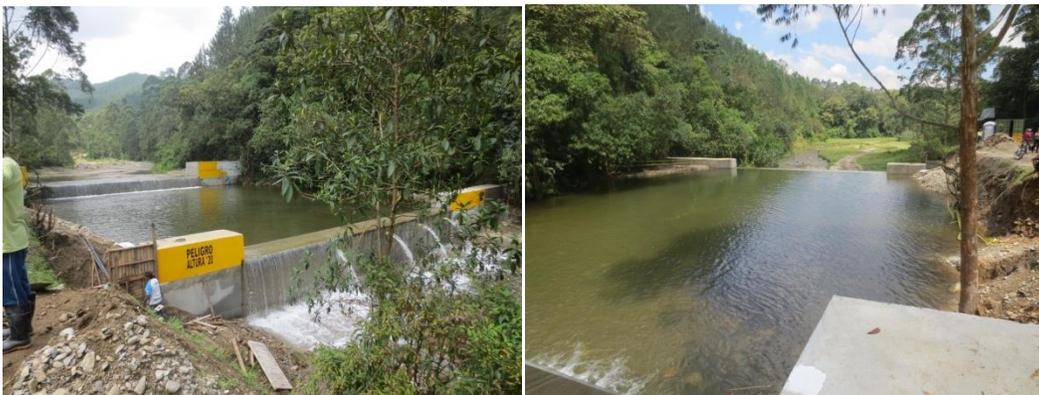
**Figura. Obras de reducción de erosión de márgenes y mitigación de inundaciones mediante el mantenimiento de la presa aguas debajo de la quebrada La Clara en el Alto de San Miguel, municipio de Caldas**
