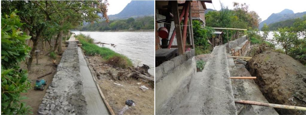
**Figura. Construcción de obras de protección en gaviones en el barrio San Jorge de la zona urbana, sobre la margen derecha del río Cauca, municipio de La Pintada Antioquia. Etapa II**
