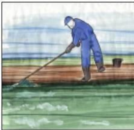
Figura No. 4. Operación de limpieza de natas en lagunas
